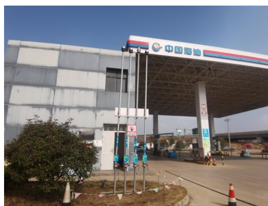
油罐通气管口
